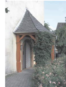
Eingang der Ev. Kirche Heidenrod-Laufenselden
